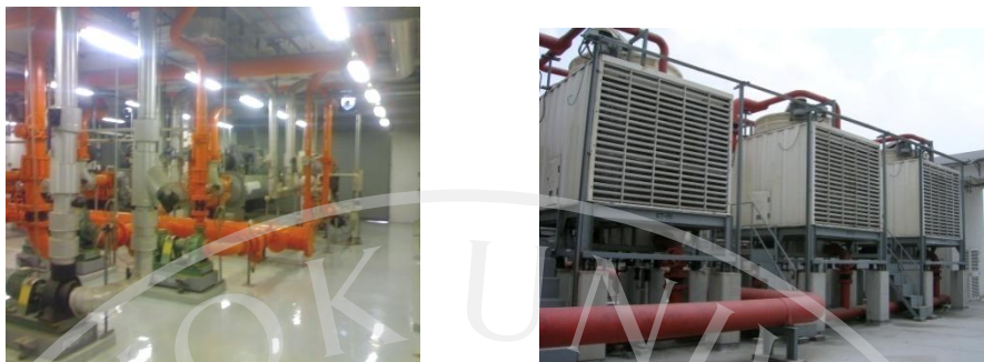
ภาพที่ 4.19 : การประหยัดพลังงานโดยการลดชั่วโมงการทำงานปั๊มน้ำและหอผึ่งเย็น
