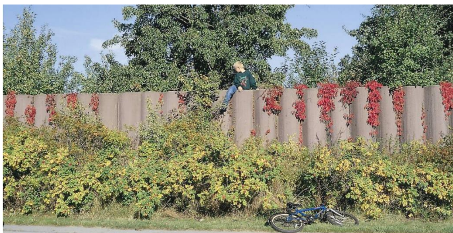
ภาพที่ 2.16 กำแพงกันเสียงจากคอนกรีตที่มีการโค้งรับเสียงและต้นไม้ปิดผิวตามถนนความเร็วต่ำที่เมือง Aarhus ถนน National ประเทศ Denmark
