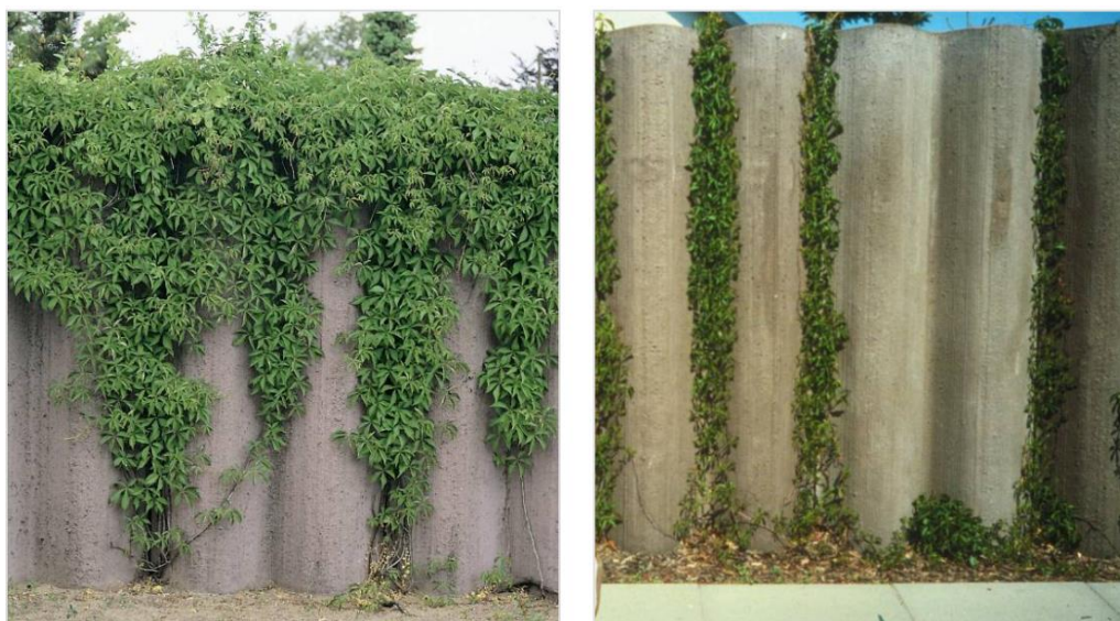
ภาพที่ 2.14: กำแพงกันเสียงทำจากคอนกรีตหนา 8 ซม. พร้อมด้วยการปิดผิวคอนกรีตด้วยต้นไม้ที่ถนน National 405 เมือง Aarhus, Denmark.
