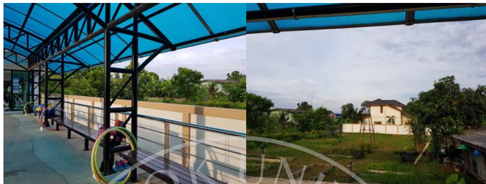
ภาพที่ 1.9 : พื้นที่ที่จะทำการก่อสร้างโซนยิม
