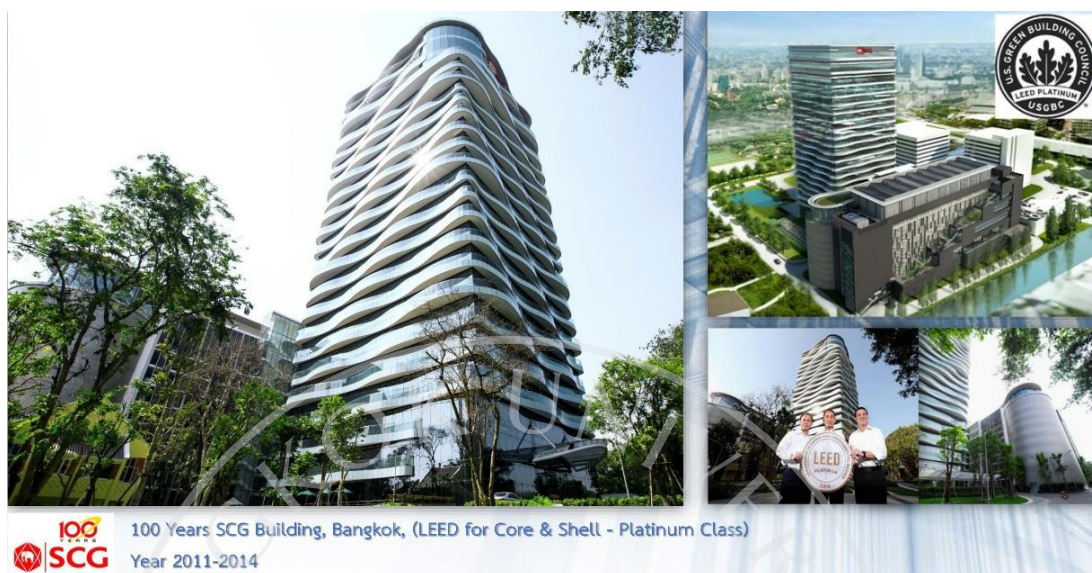
ภาพที่ 2.6: ผลงานก่อสร้างอาคาร (SCG Building)
