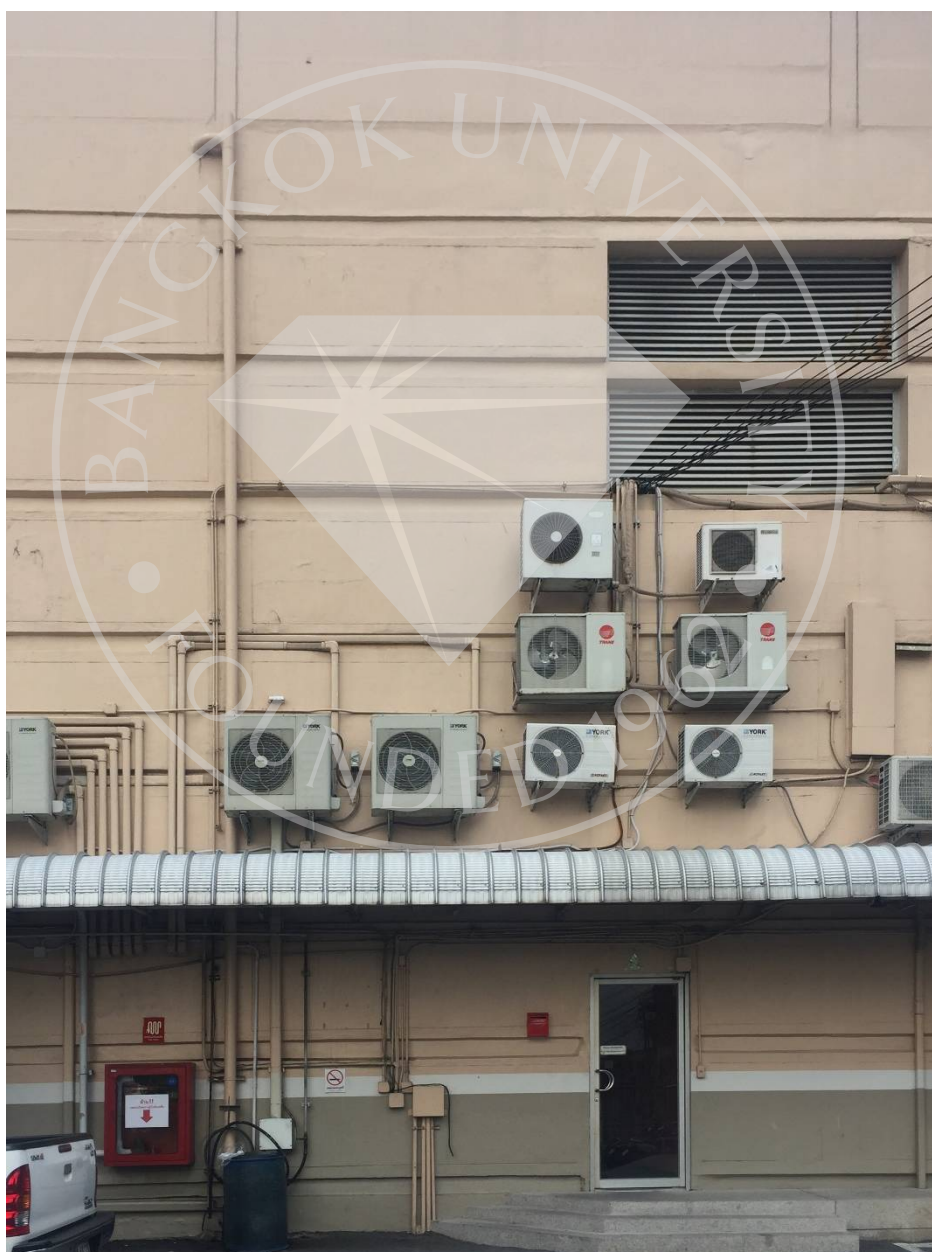
ภาพที่ 4.4: ทางเข้าสำนักงานชั้น 1
