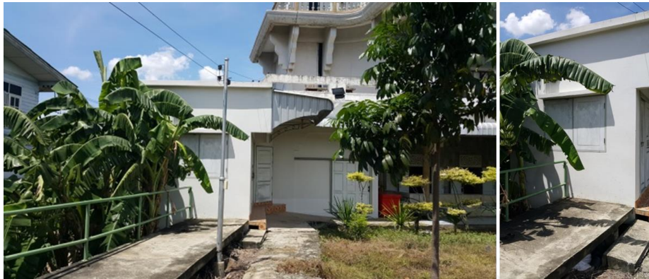
ภาพที่ 4.66: การก่อสร้างห้องน้ำ ใหม่สำหรับผู้สูงอายุ วันที่ 1 กันยายน พ.ศ. 2558
