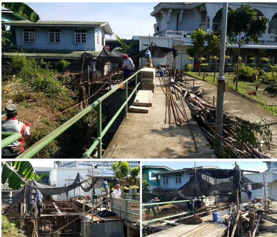
ภาพที่ 4.69: การก่อสร้างท่อน้ำ ใหม่ส าหรับผู้หญิงประจ าวนที่ 5 ตุลาคม พ.ศ. 2558
