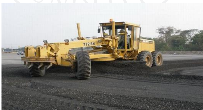
ภาพที่ 4.4 : แสดงถึงรถเกรดขณะกำลังปรับหน้าดิน
