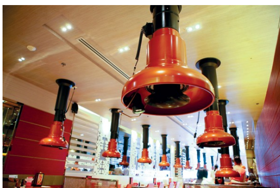
ภาพที่ 10: แสดงตำแหน่งหัวจ่ายลมเย็นและเครื่องดูดควันภายในร้านอาหาร
