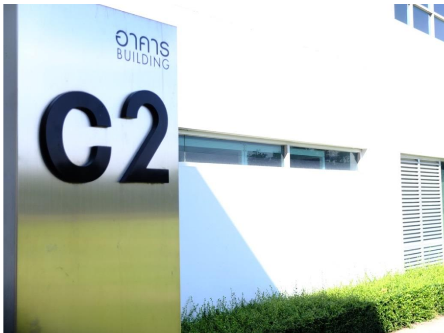
ภาพที่ 34: อาคารเรียน C2
