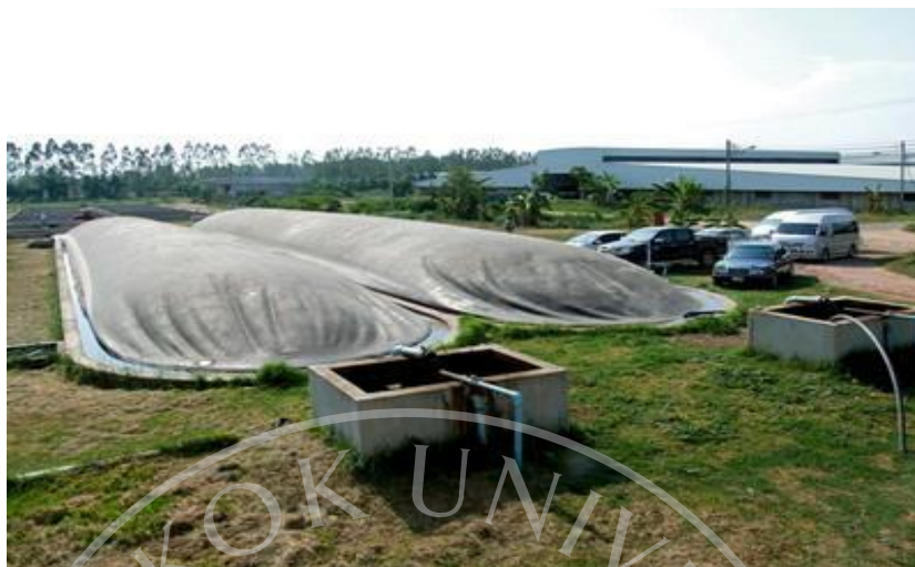
ภาพที่ 8 บ่อเก็บก๊าซมีเทนแบบพลาสติกคลุมบ่อ Cover Lagoon
