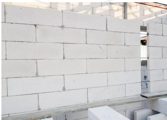
ภาพที่ 2.3: แสดงลักษณะของคอนกรีตมวลเบา (อิฐมวลเบา)
