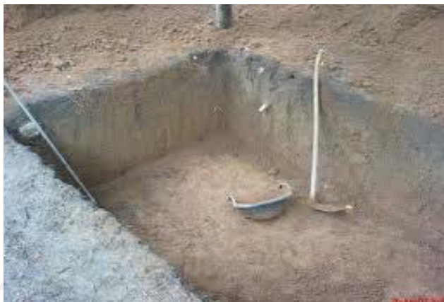
ภาพที่ 5.2: การขุดหลุมพื้นคอก แบบที่ 2
