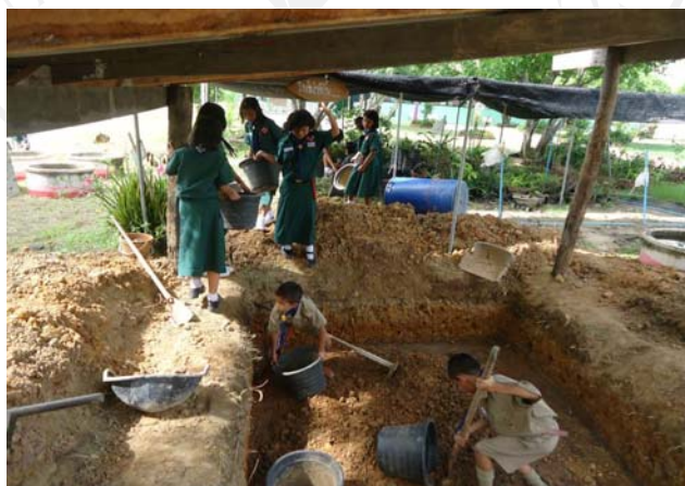
ภาพที่ 5.1: การขุดหลุมพื้นคอก แบบที่ 1
