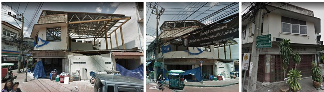
ภาพที่ 3.14: รูปภาพด้านหน้าอาคารจุดที่2 (Site B)
