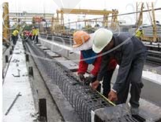
ภาพที่ 5.6 : จัดระยะเหล็ก ปลอกและผูกเหล็ก
