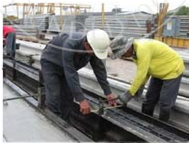
ภาพที่ 5.8 : ตรวจสอบแบบก่อนเทคอนกรีต
