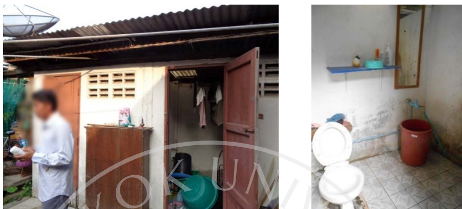
ภาพที่ 4.86: ลักษณะสภาพแวดล้อมภายนอก บริเวณซักล้าง (กรณีศึกษาที่ 5 บ้านไม้ 2 ชั้น)
