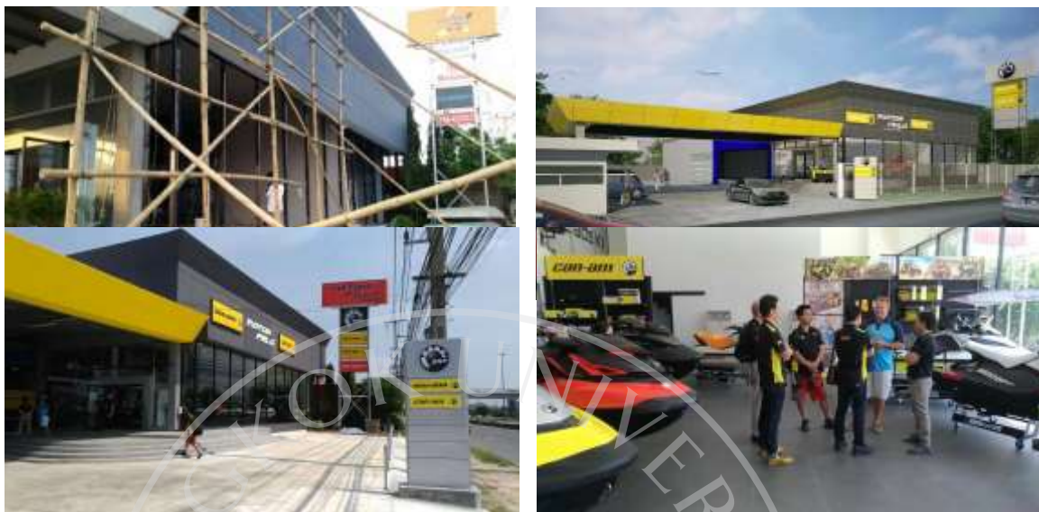
ภาพที่ 1.12 : การปรับปรุง Renovate Showroom
