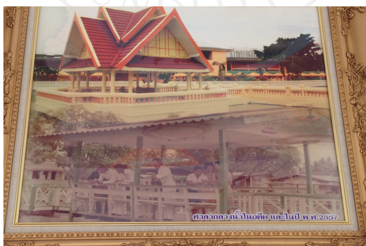
ภาพที่ 5.9: ภาพบันทึกการปรับปรุงและเปลี่ยนแปลงวัสดุศาลา
